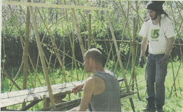
■ Jérôme et Yann font une démonstration de mise en oeuvre du plessis.
